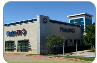
Sala de emergencias independiente
