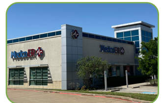
Sala de emergencias independiente
